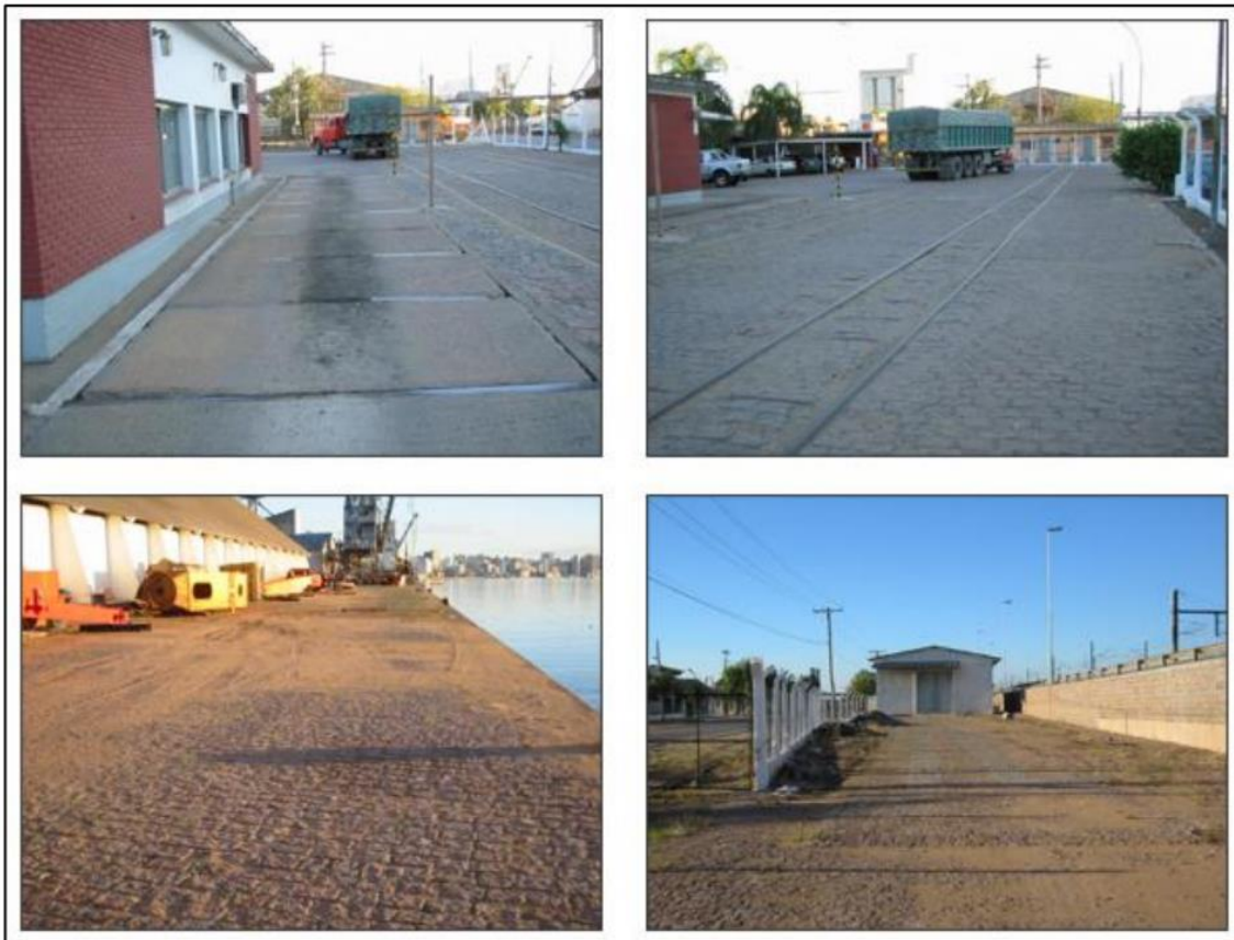
Figura 6: Pavimentação. Fonte: EVTEA NCA (2022).
