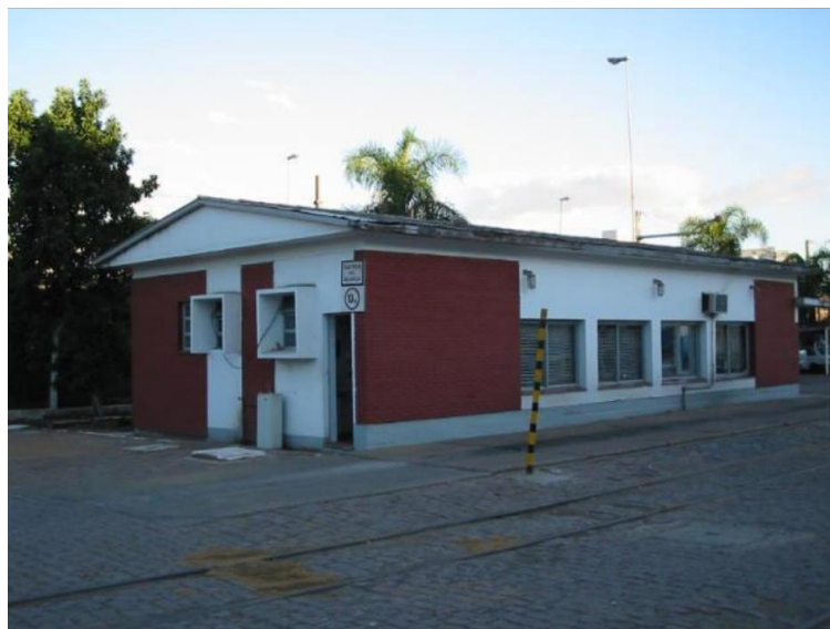
Figura 2: Prédio administrativo. Fonte: EVTEA NCA (2022).
