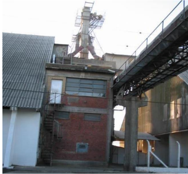
Figura 3: Torre de balança. Fonte: EVTEA NCA (2022).
